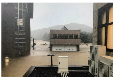
【浸水】ときがわ町 玉川トレーニングセンター駐車場
