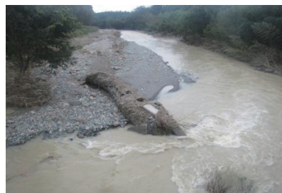
【護岸崩壊】一級河川 都幾川 ⑧【小川町腰越】
