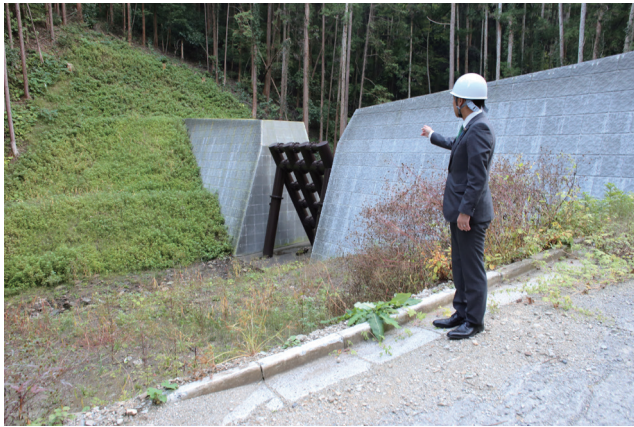
平成 27 年度竣工 小川町下里地区
