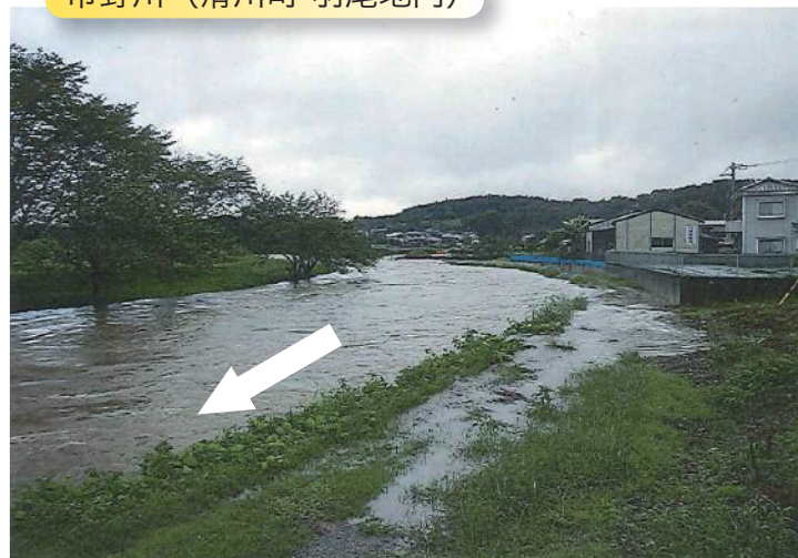
市野川（滑川町 羽尾地内）
